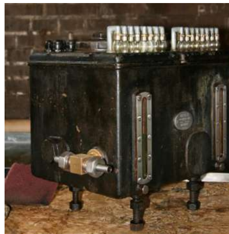
Bosch smeertoestel in ir D.F. Woudagemaal
